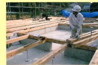
土台据え付け
