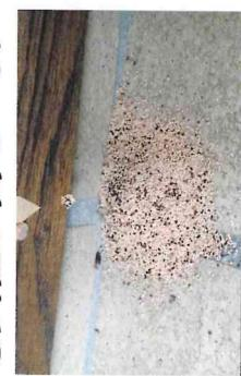
出窓、窓枠、巾木などの周囲や、玄関の扉枠の下に顆粒状の固まりがあれば、シロアリがいるサインです。よく見ると表状で6本のスジが入っています。調査を依頼される際は蕎粒の掃除はしないようにお願いします。場所の特定が難しくなり、調査結果の精度が落ちてしまうためです。
