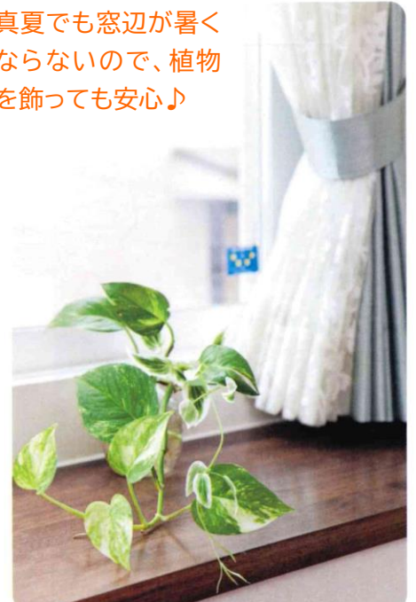
棚付き窓。断熱性の高いアルミと樹脂の複合窓に替えたことで棚の天板が結露でびしょびしょにならない!!
