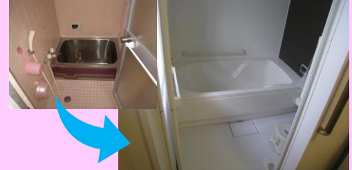
▲ユニットバスに取替え(高断熱浴槽)
