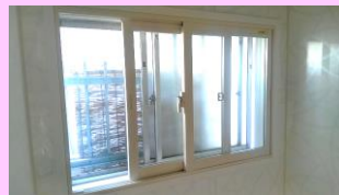
▲開口部断熱改修 内窓設置
